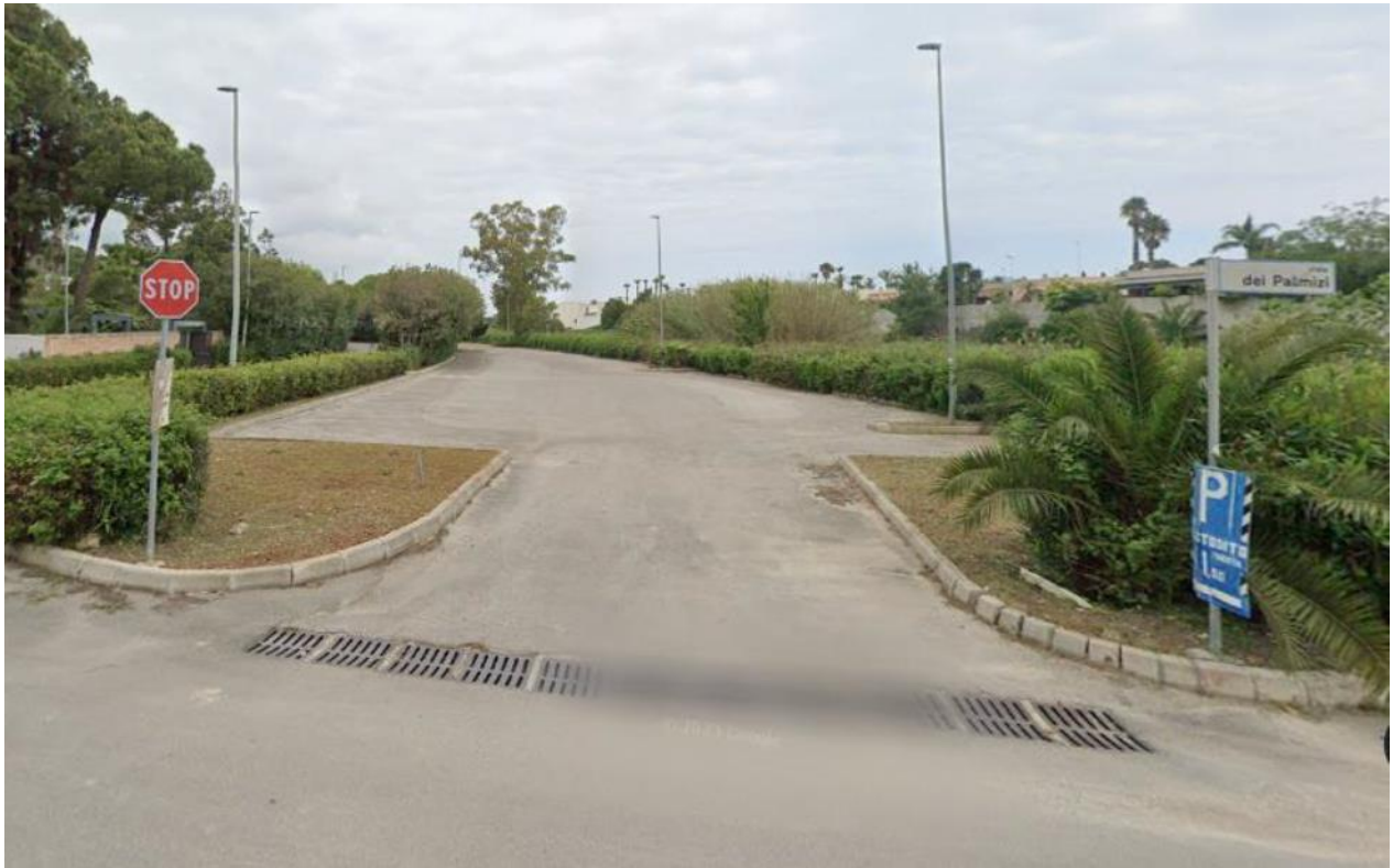
Foto 1 – accesso area parcheggio
